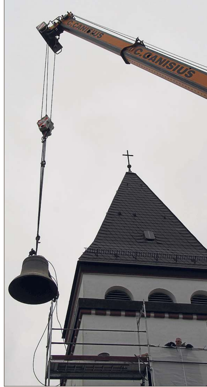
Am Dienstag hat Die Versöhnungskirche der Evangelischen Kirchengemeinde Ennigerloh ein neues Geläut erhalten. Mithilfe eines Autokrans wurden die alten Gusstahlglocken durch Bronzeglocken ersetzt.
