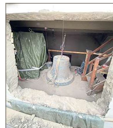
Für den Tausch der Kirchenglocken wurden die Kirchuhr im Turm ausgebaut und das Mauerwerk entfernt.
